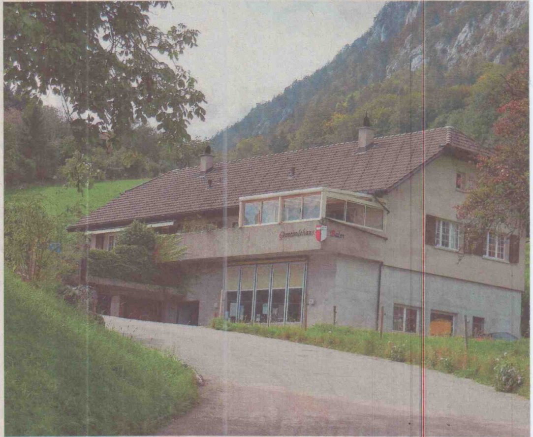
Das Gemeindehaus wird saniert, aber nicht ausgebaut.
